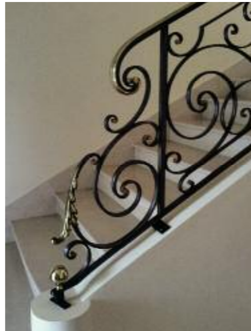
Ci-dessus : restauration de la verrière éclairante de la salle de l'Assemblée générale, au Conseil d'État. Ossature métallique avec remplissage par cadres en laiton et vitrage dépoli. Dimensions : 5 x 11 mètres. Ci-contre : départ de rampe d'escalier sur un chantier privé à Paris. Main courante et feuillages en laiton, volutes et structure en acier.
