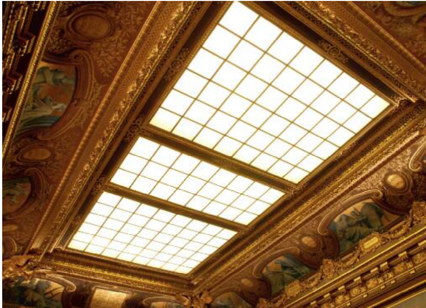
Ci-dessus : restauration de la verrière éclairante de la salle de l'Assemblée générale, au Conseil d'État. Ossature métallique avec remplissage par cadres en laiton et vitrage dépoli. Dimensions : 5 x 11 mètres. Ci-contre : départ de rampe d'escalier sur un chantier privé à Paris. Main courante et feuillages en laiton, volutes et structure en acier.
